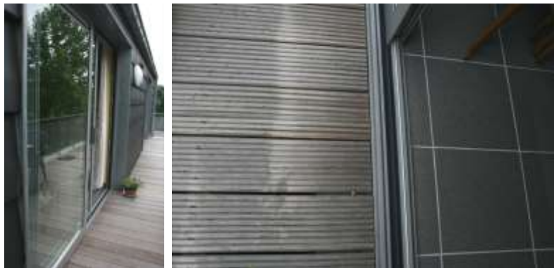
drempelloze overgang naar terras vanuit leefruimte
