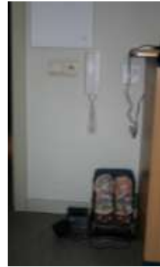
parlofoon, stopcontact en lichtschakelaar op hoogte
